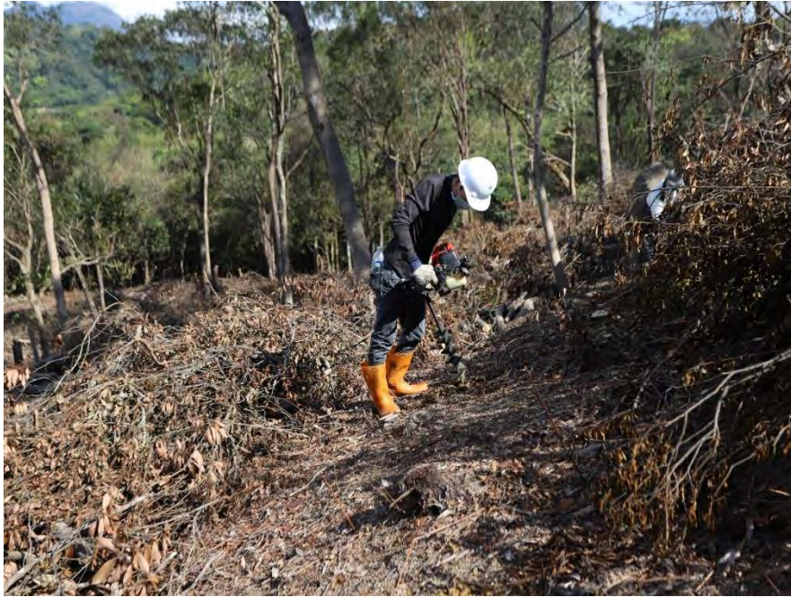
圖 26 以鑽洞機進行植穴開挖
